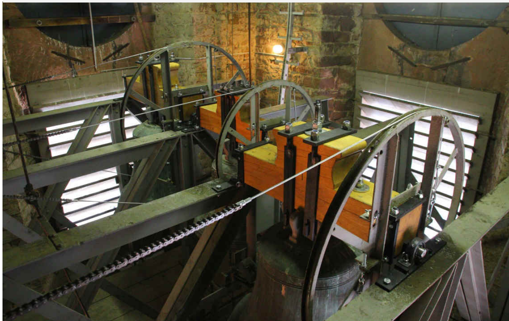
Abbildung 5: Nach der Sanierung hängen die Glocken an Barockjochen aus massiver Eiche
