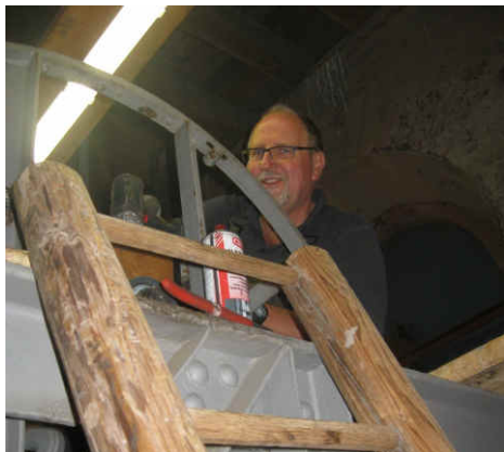
Abbildung 4: Einer der Techniker bei der Arbeit am Glockenstuhl
