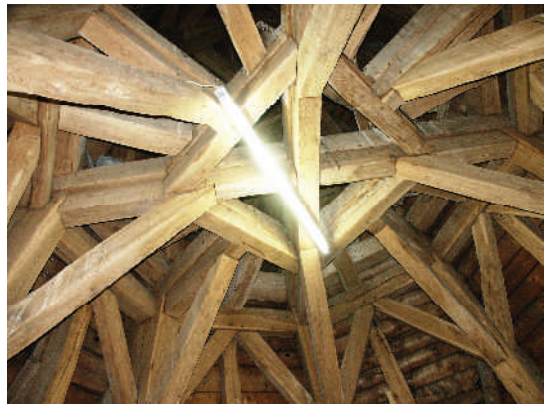
Der Dachstuhl des Glockenturms heute
